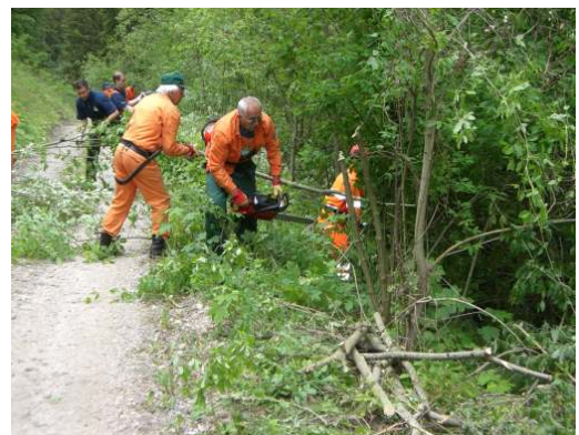
● Pulizia della strada con abbattimento alberi.
