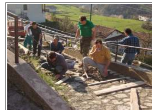
Durante i lavori....
