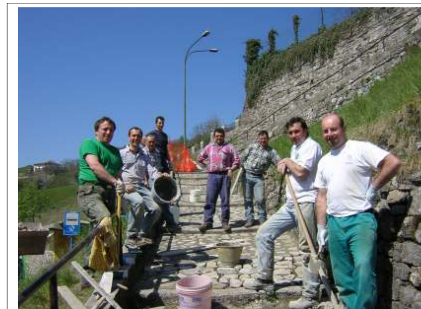
Operai del Cantiere Chiesa Capovalle.
