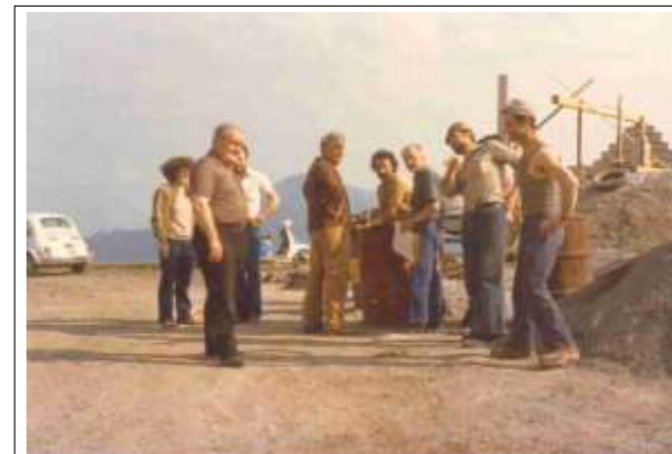
Luglio 1979 - Il cantiere della Chiesetta
