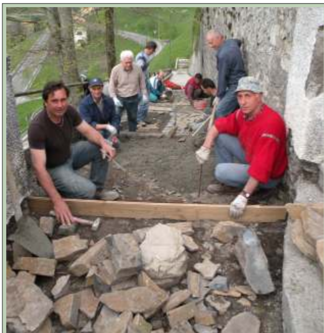
La squadra assegnata al lavoro sulla scalinata.
